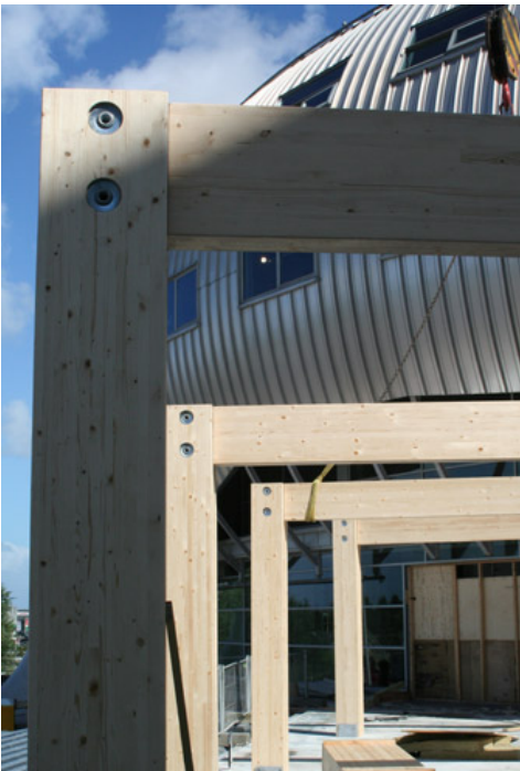
De spanten die hier links zijn afgebeeld vormen de constructie van de buitenste ring.
